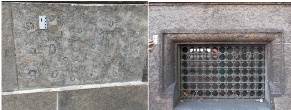
Figura 5: Intervenção inadequada no preenchimento de porfiroblastos no CCBB e crosta negra e excesso de produto no CCJE.
