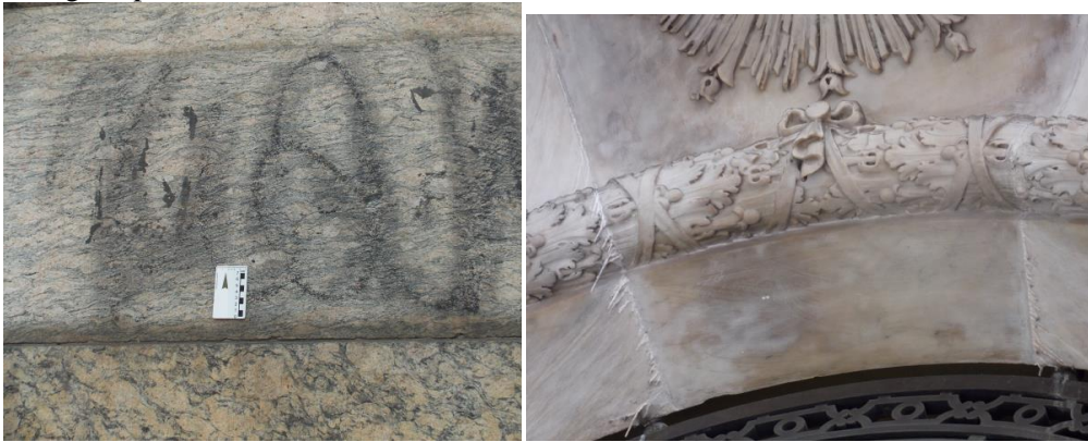
Figura 4: Mancha de pichação na Igreja da Candelária e mármore em solução no CCJE.
