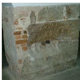
Figura 2: Pilastra degradada. Gráfico 4: Composição química da água que lavou parte da pilastra.
