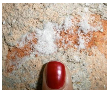
Figura 3: Eflorescência no tijolo do pavilhão Del Rey. Gráfico 5: Composição química do sal que cristalizava por eflorescência na pilastra do pavilhão Del Rey.
