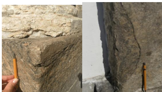
Figura 1: Exemplos de patologias de deterioração: a primeira apresenta uma perda de massa do calcário (superior) e intervenção inadequada (colagem de quina); a segunda apresenta uma combinação entre deslocamento, perda de massa e crosta negra.
